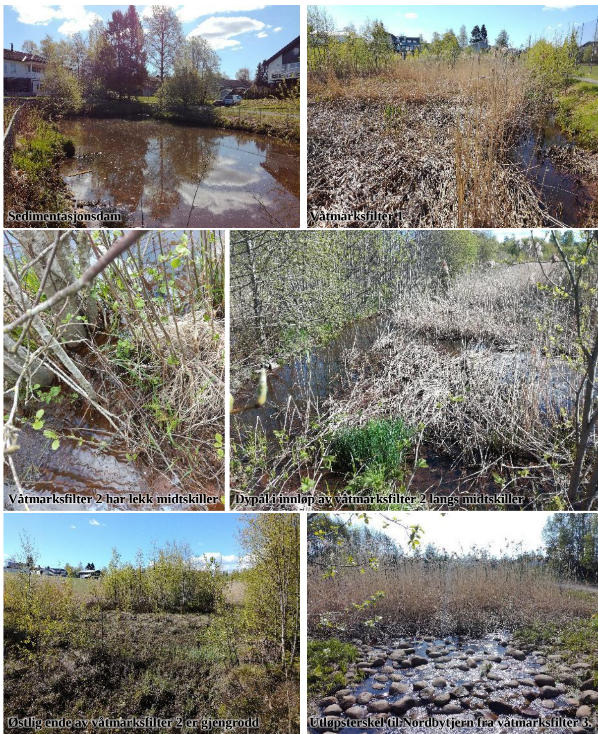
Figur 5. De ulike delene av renseparken preges av manglende vedlikehold: full sedimentasjonsdam, gjengrodde våtmarksfilter og nye vannveier som reduserer rensearealet og dammens renseeffekt.
